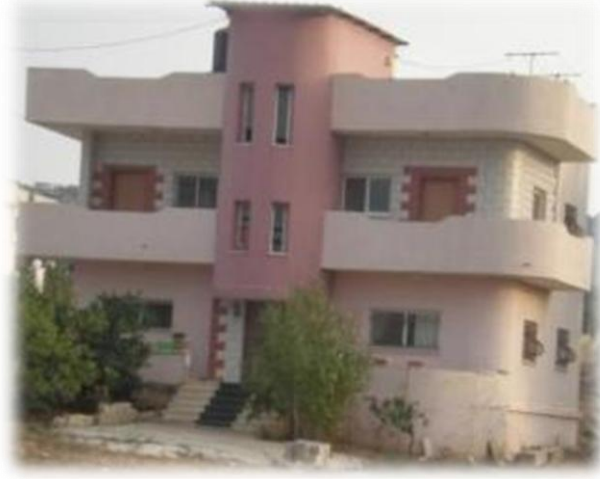
شكل (8-5): صورة توضح مبنى سكني واجهاته ملونة و مبني من الطوب الإسمنتي
