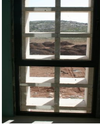
شكل (5-38): تفصيلة من الداخل للكاسرات الأفقية والعمودية ذات العمق الداخلي
