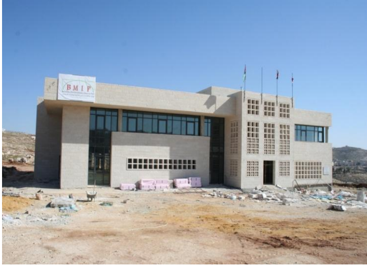
شكل (5-37): الكاسرات الأفقية والعمودية ذات العمق الداخلي
