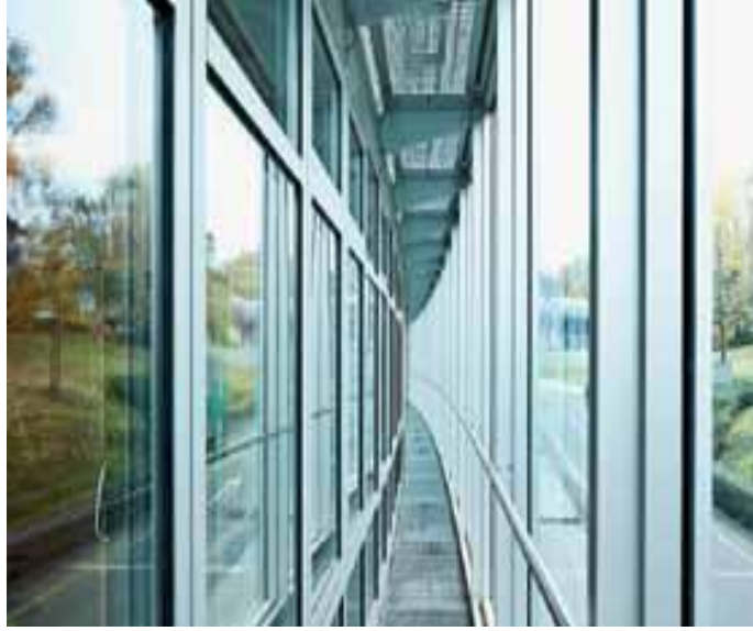
شكل (20-5): صورة تبيّن نظام الواجهات الزجاجية ذات الغلاف المزدوج مع ممر بينهما
